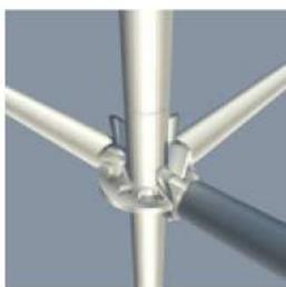
**(5)** Para o próximo nível, verificar no projeto em qual roseta deverá ser encaixado a horizontal. A separação entre as rosetas é de 50cm de altura.
