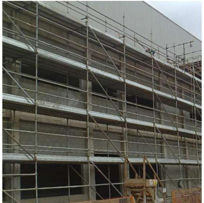
O acesso pode ser realizado através da plataforma com alçapão ou até mesmo escadas de alumínio pela parte de fora da estrutura garantindo a passagem livre na parte interna da torre.
